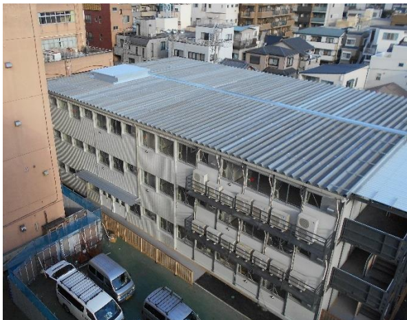
<校庭に建設された3階建ての仮設校舎>
